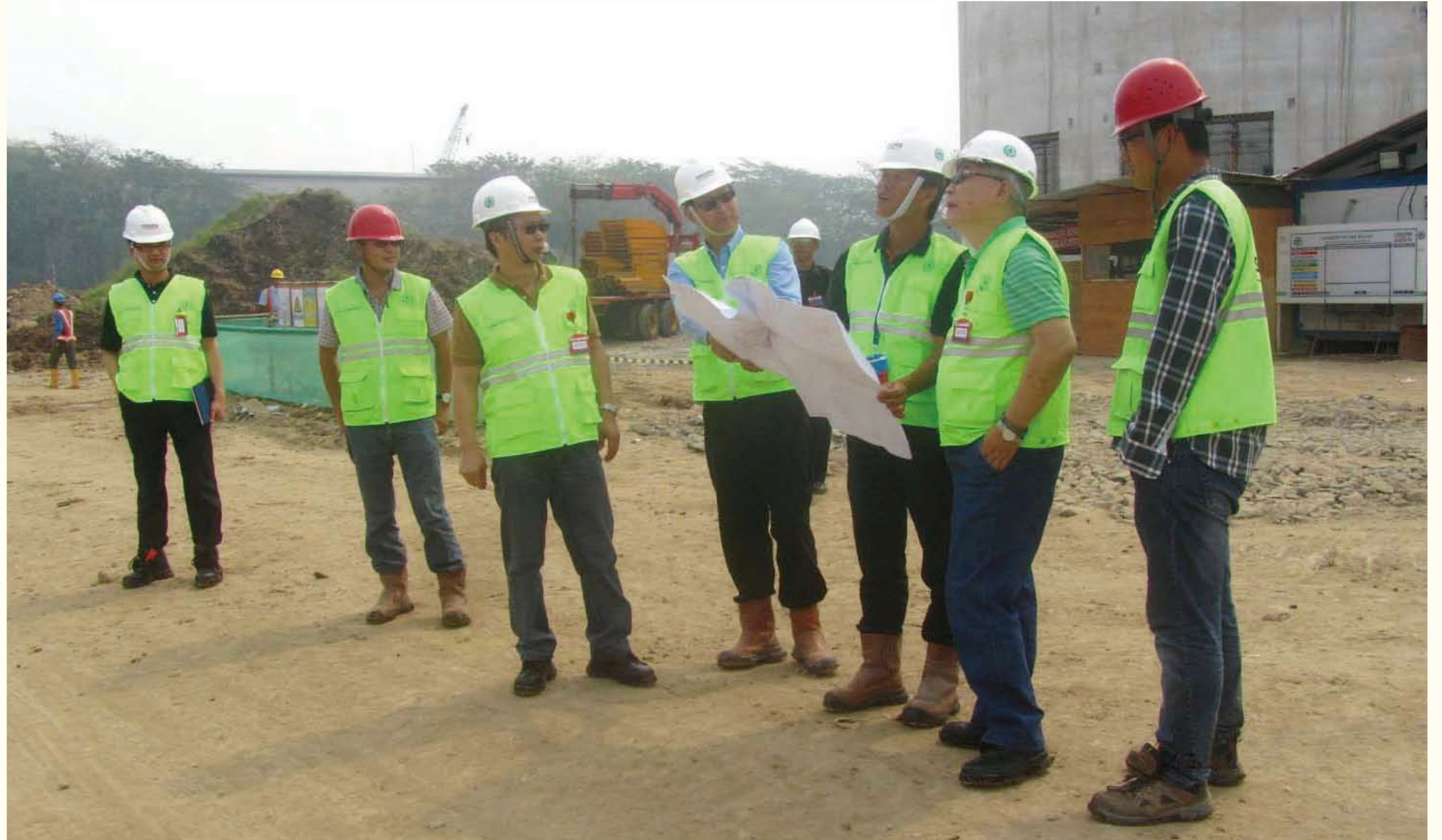
王伟（右二）一行在印尼海德堡项目现场检查工作
