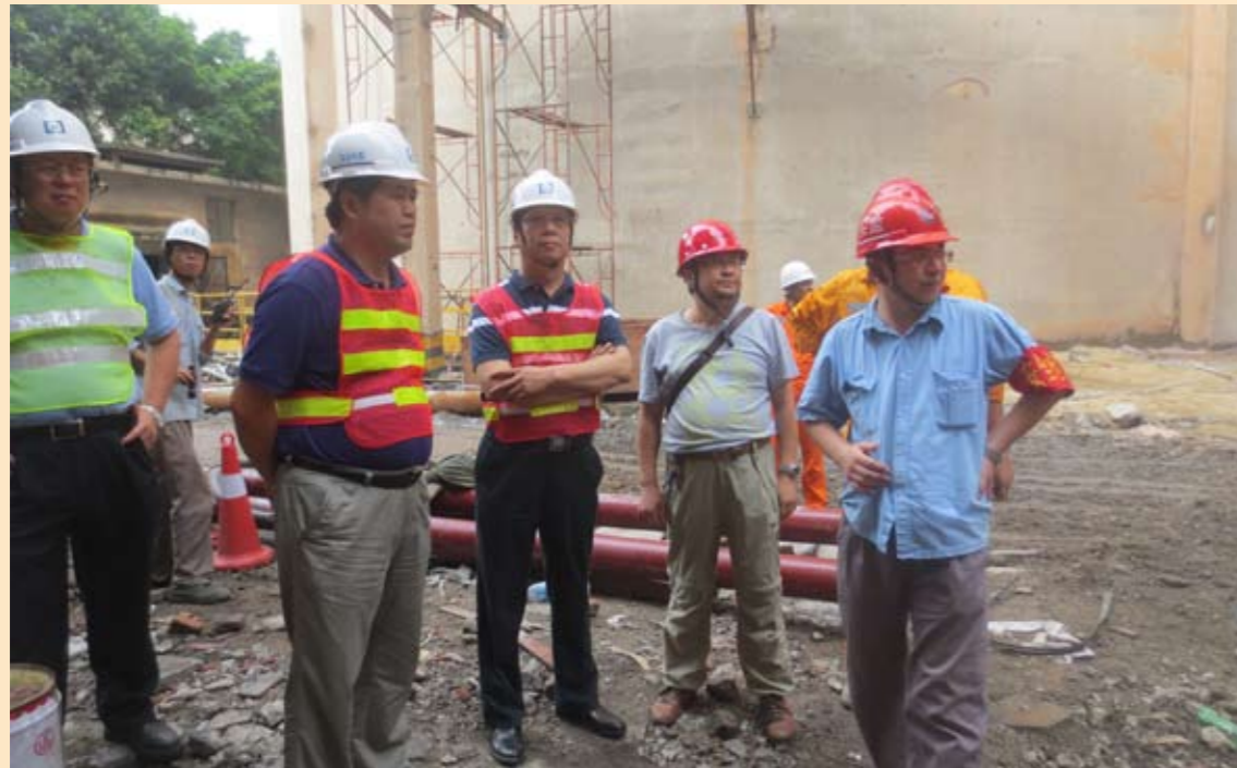
徐培涛、石稳龙在项目现场检查点火工作
