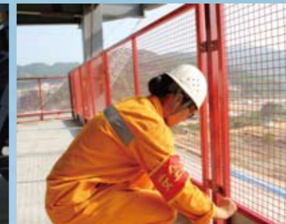
《临边防护检查》——范炳均 摄影
